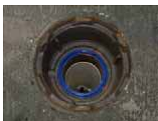
Anillo de montaje en canalización
